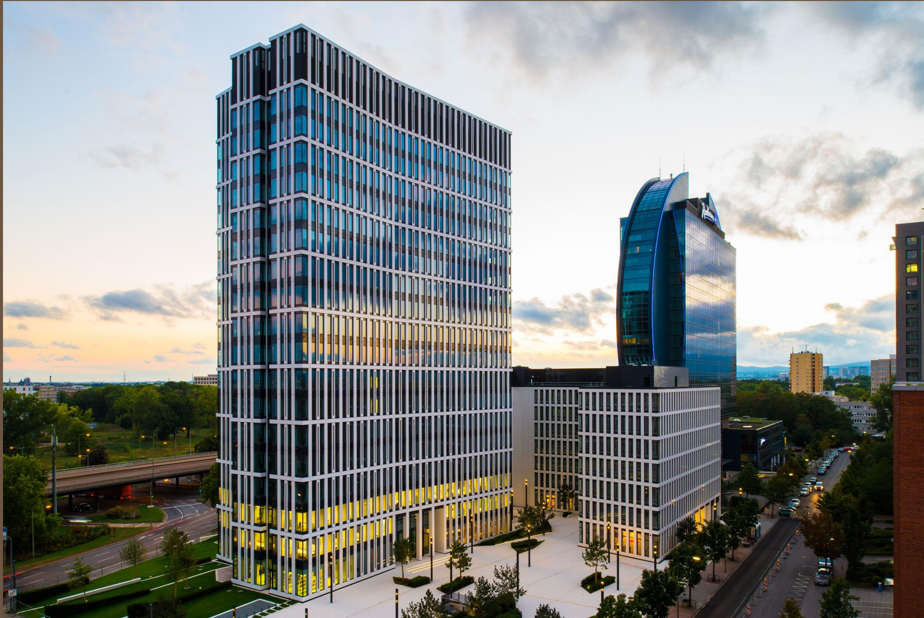
Einsatz des Last Planner® Systems in der Planungskoordination beim Projekt St Martin Tower Frankfurt
